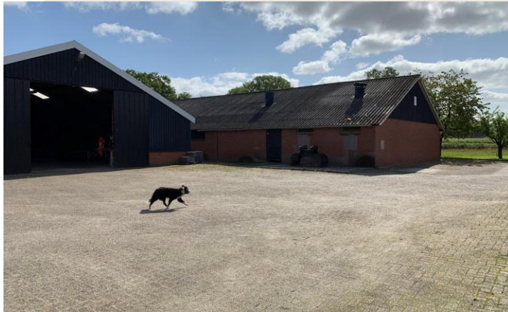
Bestaande werktuigenloods en stal
